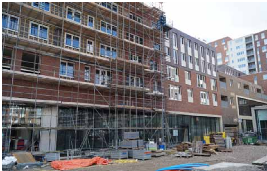
De 24 woningen zijn in de afbouwfase.
