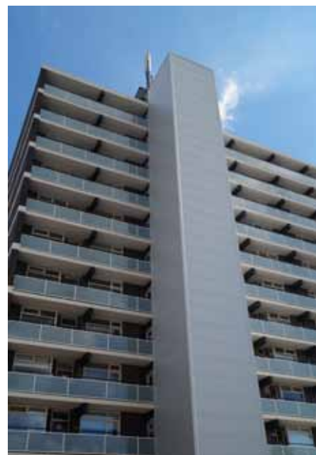
In de voormalige liftschacht zit nu de rookgasafvoer van de parkeergarage.
